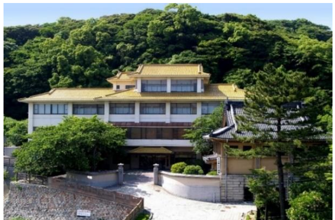
下関春帆楼本店 外観
