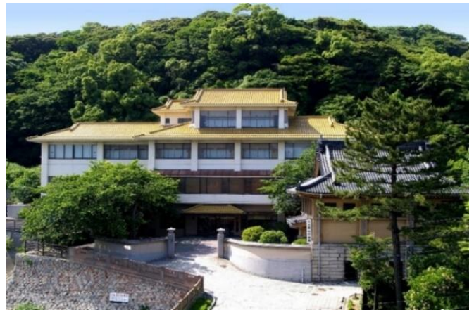
下関春帆楼本店 外観
