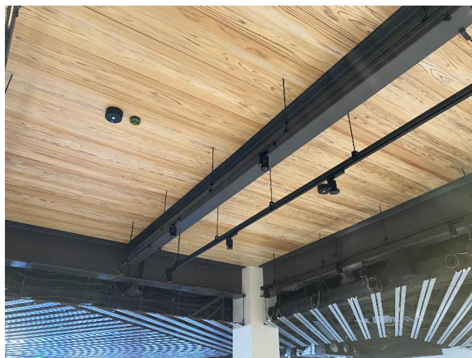
▲公園施設天井デッキ
