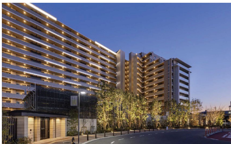
「ライオンズ茨木総持寺ステーショングラン」外観
