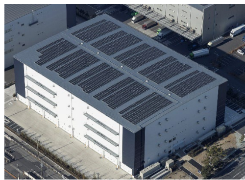
屋根に設置した太陽光発電設備
