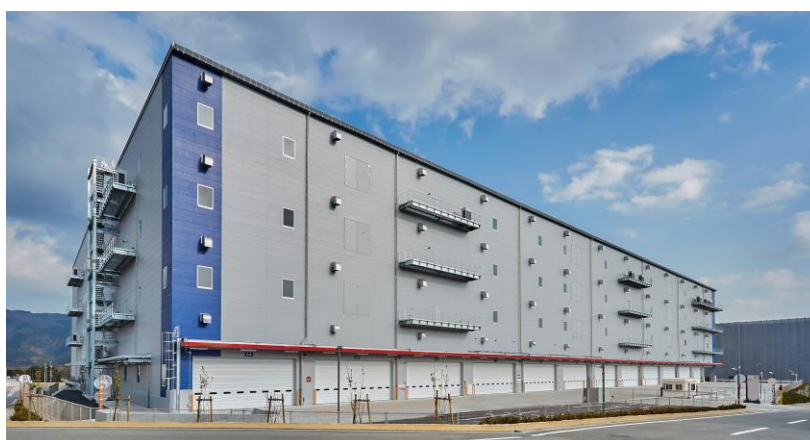
「箕面ロジスティクスセンター」外観
