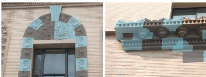
2階窓枠テラコッタ
