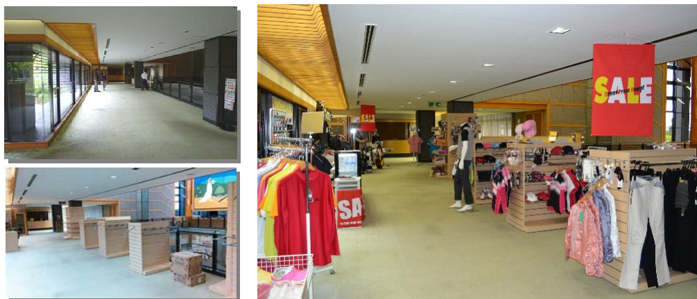
写真左上：移設前 左下：工事中 右：完成後
