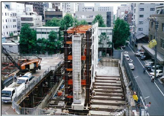
既設外壁の補強鉄骨ごと移動
