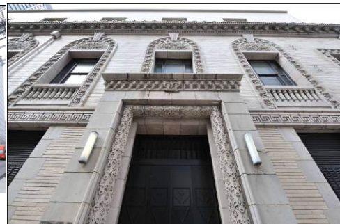
増築改修後のビル外観
