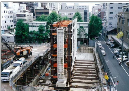
既設外壁の補強鉄骨ごと移動
