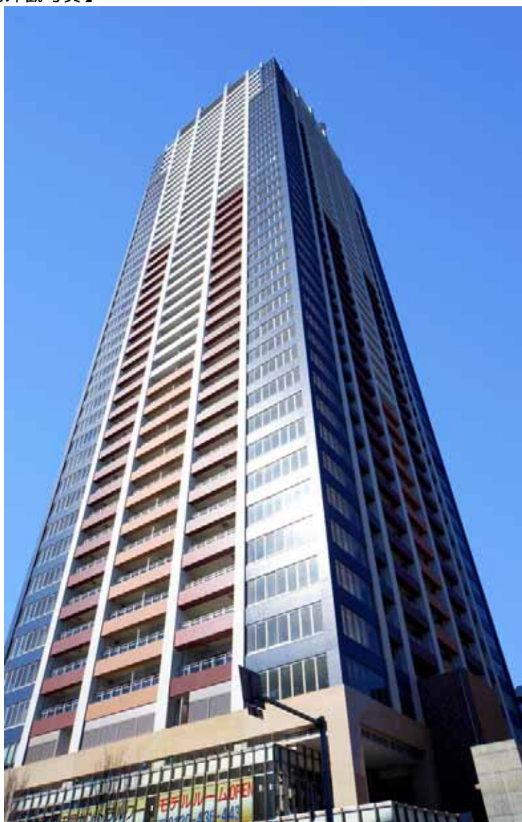
【建物外観写真】
