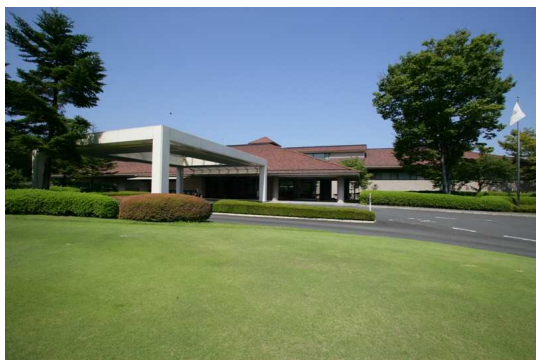
▲ クラブハウス外観
